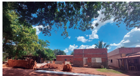
Andamento da obra
